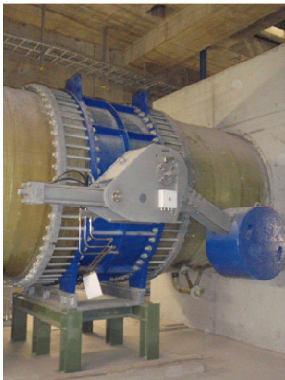
Zdjęcie nr 4. Kłapa zaporowo zwrotna VAG EKN DN 2800 z napędem elektrohydraulicznym HB-HV ( \zeta \cong 0,55 ) Blok energetyczny 900 MW - Niemcy
