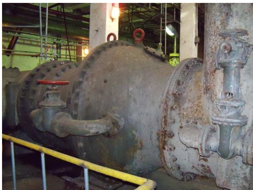
Zdjęcie nr 1. Armatura na rurociągu tłocznym przed modernizacją Pompowni Centralnej ZE PAK - El Konin
